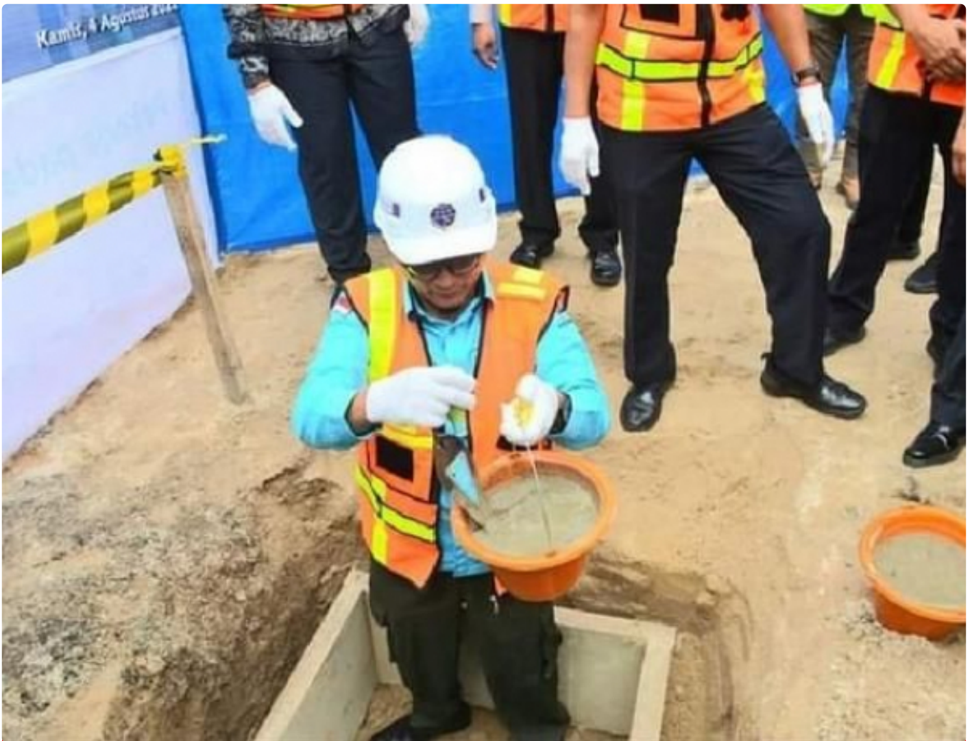
Pembangunan Shelter Kereta Api
